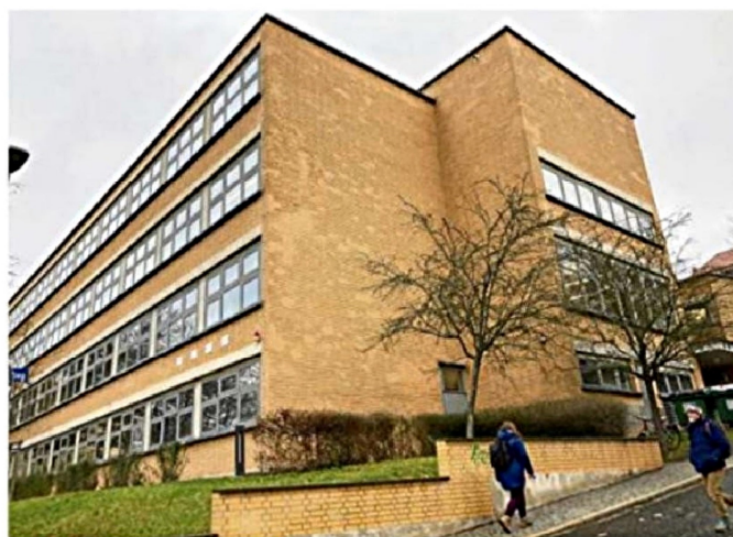
Das Abbeanum befindet sich am Fröbelstieg. Straubel gehörte zu den Initiatoren des Baus. Der Stahlbetonskelettbau wurde 1930 von Otto Bartning und dem Bauhausschüler Ernst Neufert im Auftrag der Carl-Zeiss Stiftung entworfen und erbaut.
