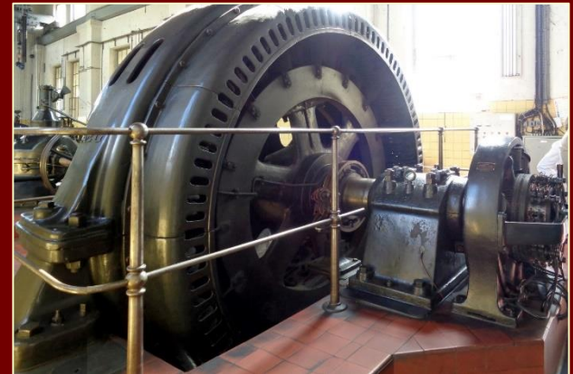
10 kV-Generator im Burgauer E-Werk, 2017
