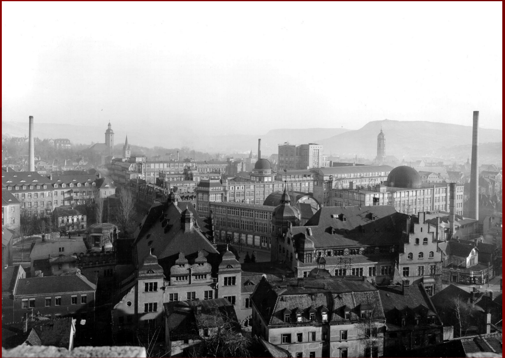
Die Werksternwarte im Zeiss-Hauptwerk von 1908, die provisorische Planetariumskuppel auf dem Fabrikdach, das Abbe-Denkmal, die Astro-Montagehalle und Abbes Wohnhaus
