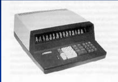
1968: ETR222 Sömmerda, IS, 16stellig, Ziffern- Anzeigeröhren, Magnetstreifen
